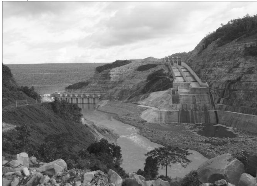
Barrage de Bakun
