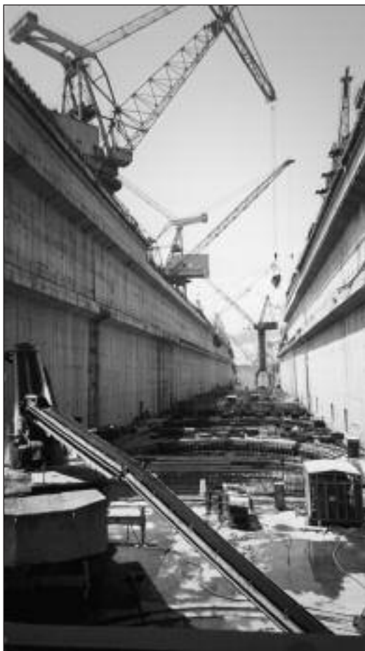
Construction du barrage des Trois Gorges (août 2001).
